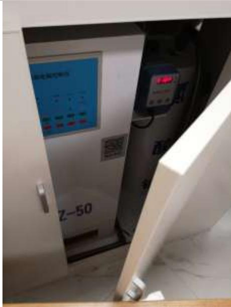
图3 二氧化氯污水处理设施现场照片
